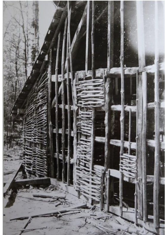
Afb. 10: Vitselwerk zuidelijke sluitgevel van het bakhuis uit Heist-Goor tijdens de opbouw ervan in Bokrijk in 1964.
