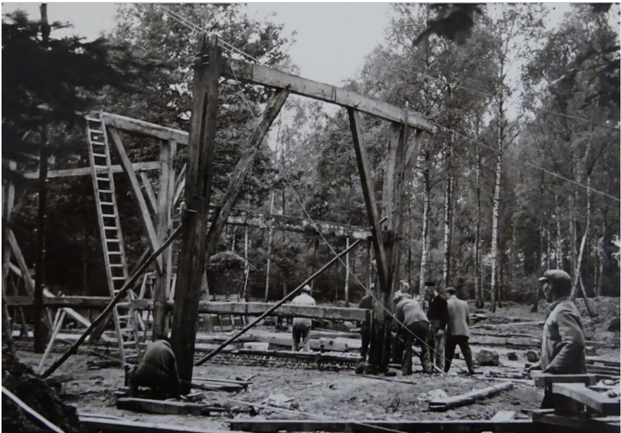
Afb. 9: Het optrekken van het laatste gebint van de Uitschoolhoeve uit Oevel te Bokrijk in 1954.
